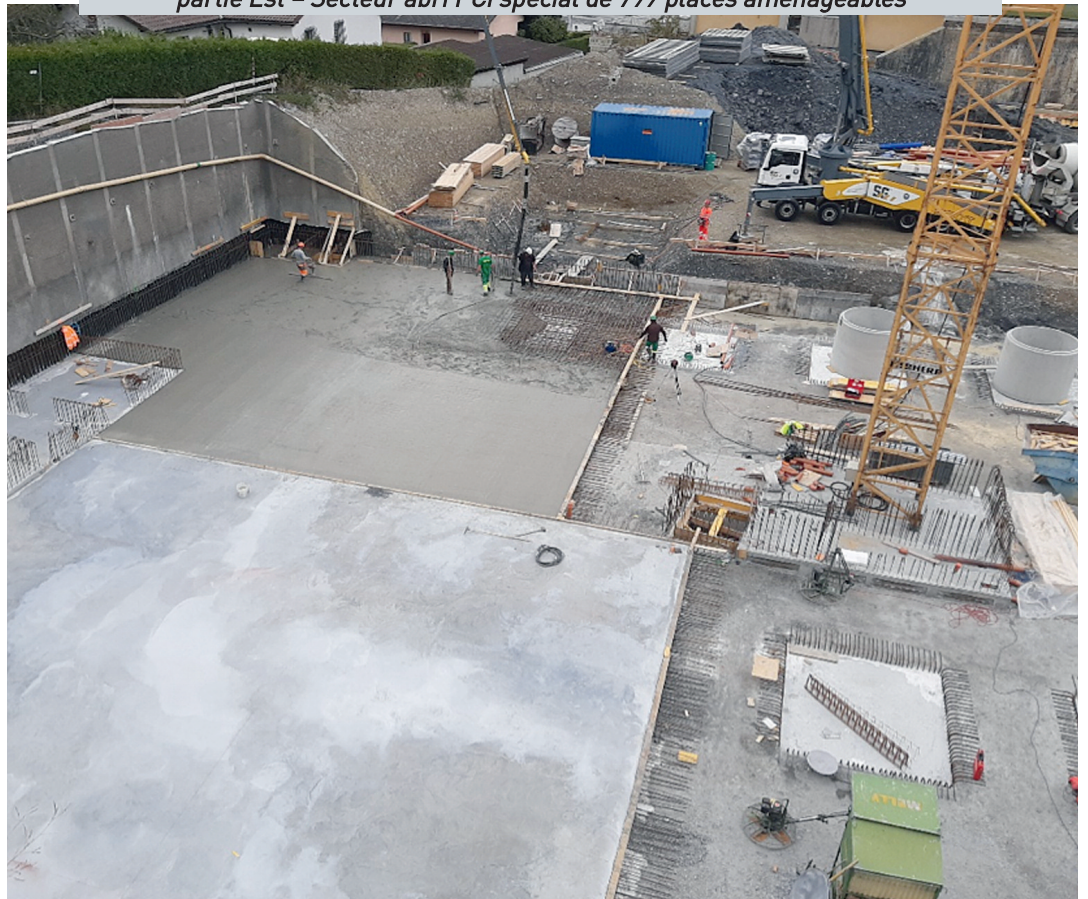
Le 28 octobre 2019, niveau -3 m - Bétonnage d'une étape de radier partie Est – Secteur abri PCI spécial de 799 places aménageables
